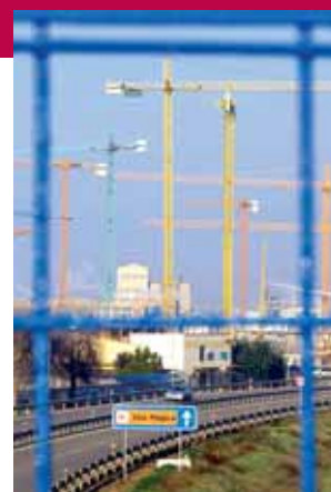
Construcción de viviendas.
